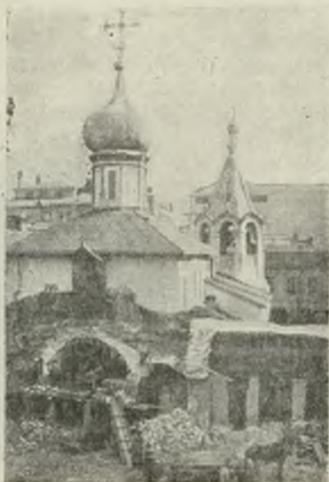
Рис. 4. Гребневская ц.: удалены западные пристройки, восстанавливается портал (1927 г.).
