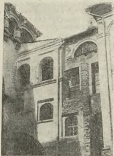
Рис. 1. Московский Кремль: переходы от Теремов к ц. Ризположения; удалена поздняя пристройка, раскрыты заложенные окна и пролеты арок (1927 г.).
