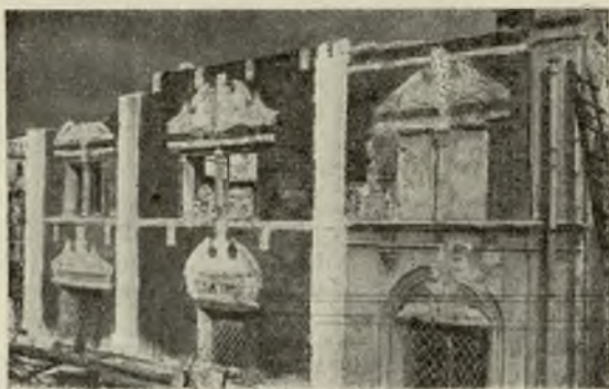
Рис. 8. Ц. Параскевы в Охотном ряду: сев. стена с открытыми от штукатурки белокаменными наличниками окон (1928 г.).
