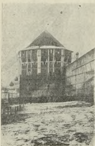
Рис. 12. Пятницкая башня б. Троице-Сергиевой лавры. Сгоревшая кровля восстановлена по древнему типу (1925 г.).
