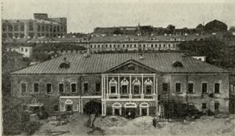
Рис. 7. Дом б. Голицына в Охотном ряду. Правое крыло нетронуто, левое - же освобождено от штукатурки. Белой окраской выделены реставрированные детали (весна 1928 г.).
