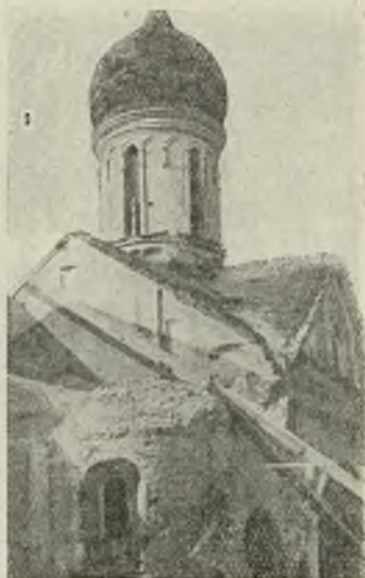
Рис. 6. Ц. Николая в Мясниках. Северо-восточный угол церкви после удаления позднейшей сев. пристройки и снятия желез. покрытий (1928 г.).
