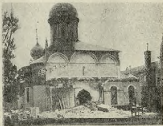
Рис. 13. Троицкий собор б. Тр.-Серг. лавры. Разборка северной пристройки; стена освобождается от окрасок, среднее окно восстановлено (1926 г.).
