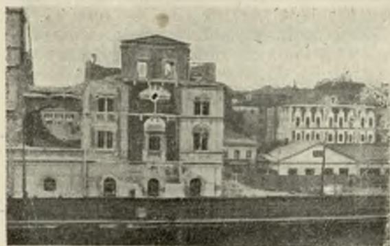
Рис. 9. Ц. Параскевы: в средней и левой части вскрыты белокаменные наличники окон. Слева за аркой д. б. Голицына, справа д. б. Троекурова (1928 г.).
