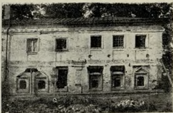
Рис. 16. С. Коломенское: восстановление измененных окон Ключничьих палат (1928 г.)
