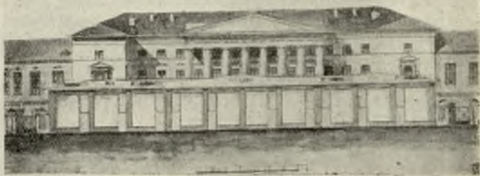
Рис. 10. Б. Английский Клуб по Тверской: решетка уничтожена, фасад скрыт торговой постройкой (с проектного чертежа) до 1919 г.
