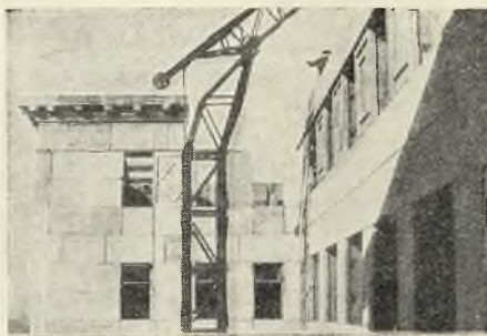
Строительство Таганской больницы из крупных блоков. Москва. Арх. А. Г. Климухин Construction de l'hôpital Taganski en blocs artificiels. Moscou. Arch. A. G. Klimoukhine
