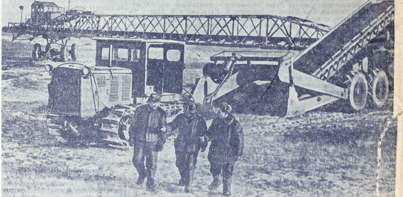
На трассе строительства канала Волга — Урал начала работу новая землеройная машина «Д-264».
