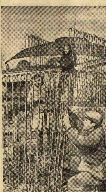
Бригада арматурщиков И. ШАПОВАЛОВА заготовила детали для бетонирования основания платформы «Электровозная» Московско-Грязанской железной дороги.
