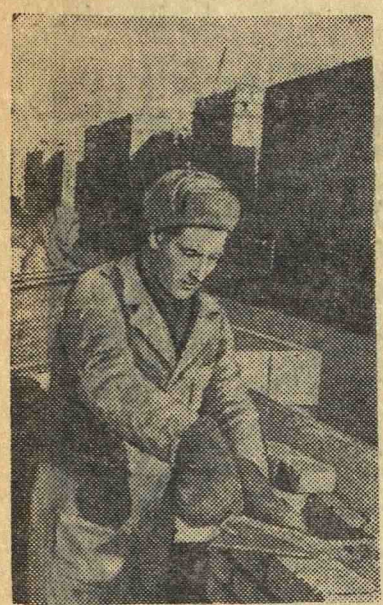
На строительстве жилого дома № 74/83 по Можайскому шоссе работает депутат Верховного Совета РСФСР Ф. Шавлюгин. Он систематически в четырех-пяти раз перекладывает дневную норму выработки. НА СНИМКЕ: Ф. Шавлюгин за работой.
