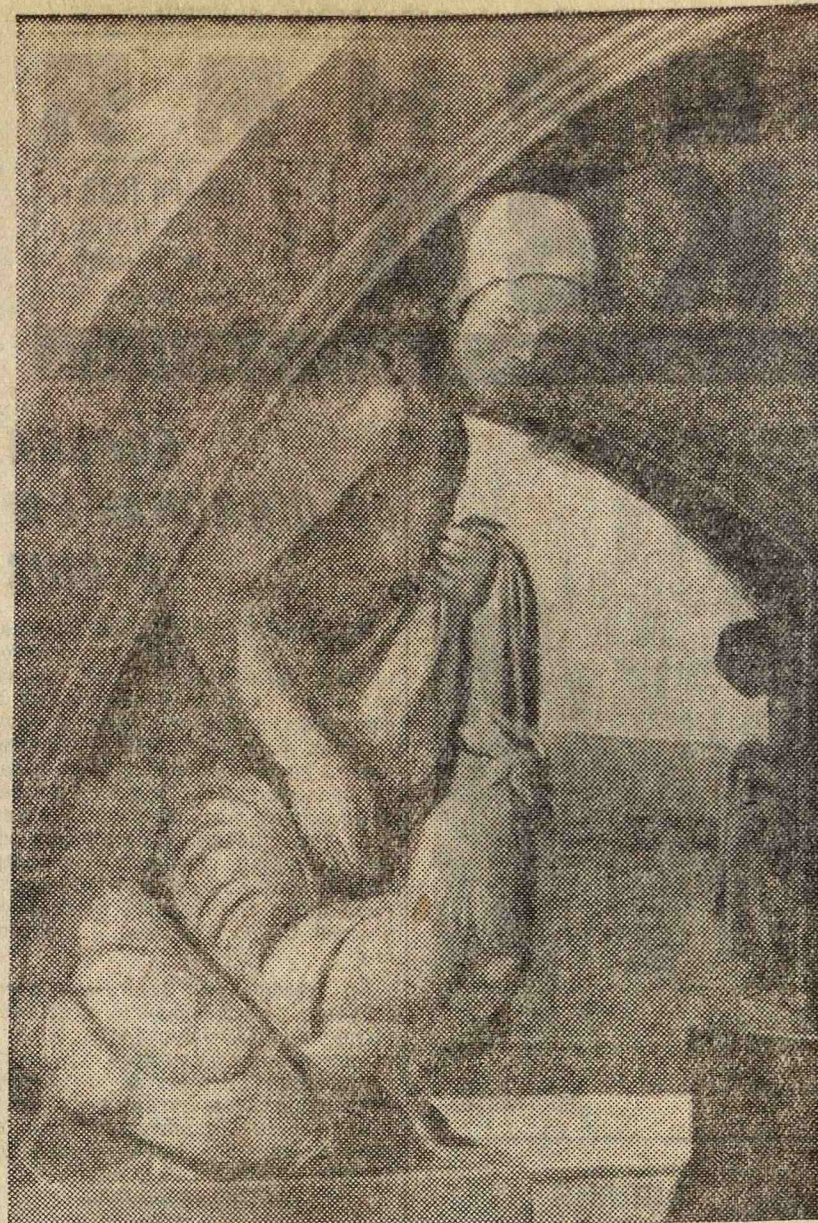
Часть платформы станции второй очереди метро «Площадь Революции». Фото Вл. Минкевича.
