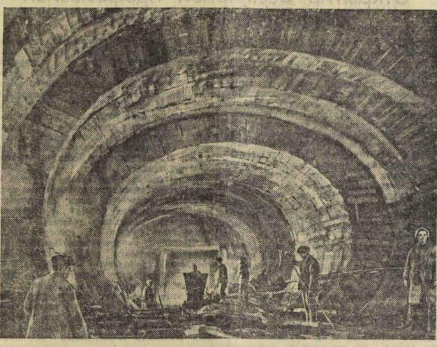
На строительстве Большого кольца метро. На станции «Курская» сооружается большая подземная камера с ездом — для перехода поездов из одного тоннеля в другой. Фото Г. Тетереватникова.
