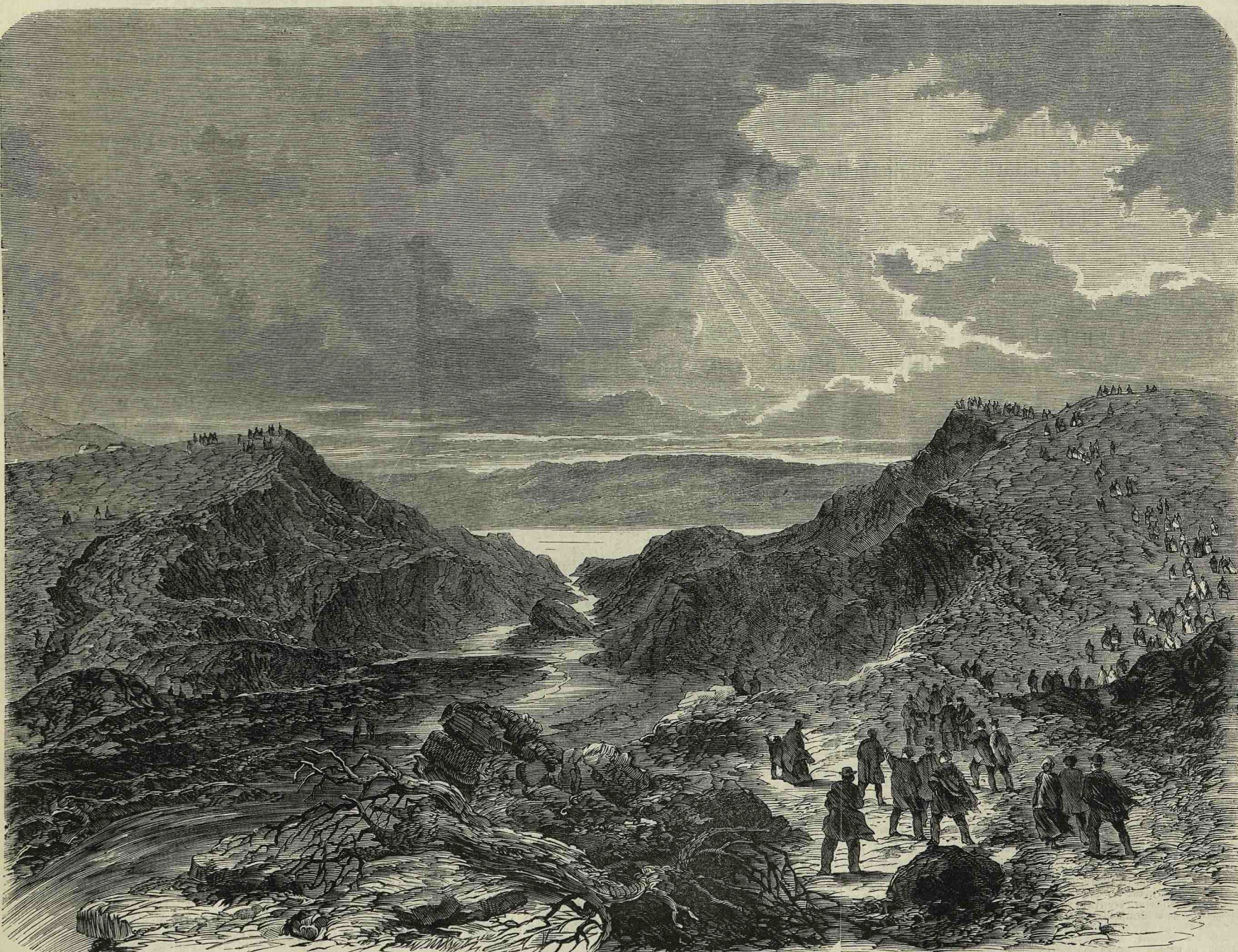
Der durchbrochene Damm des sheffelder Wasserbehälters. (S. Seite 224.)
